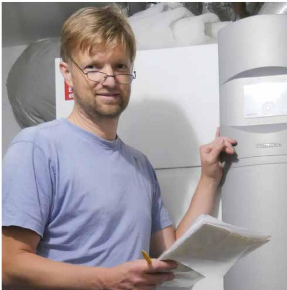
Das sind insgesamt ca. 175 Quadratmeter Zimmerfläche. Wir haben überall Fußbodenheizung. Unsere Wärmepumpe ist eine sogenannte Luft-Wasser-Wärmepumpe. Sie saugt Außenluft an, entnimmt ihr Wärme, mit der sie schließlich Wasser erwärmt und die abgekühlte Luft wieder nach draußen bläst. Die Wärmepumpe erwärmt unser Brauchwasser im Warmwassertank und den Wasserkreislauf unserer Fußbodenheizung.
