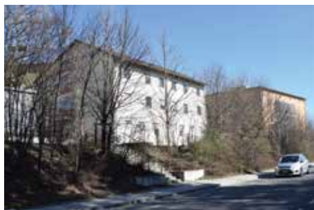
Die alte Klinik an der Münchener Straße wird abgerissen, um Platz für den Neubau der Zentralen Notaufnahme zu schaffen.
